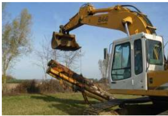
Figure 30 : Extraction des fagots du lac à la pelle mécanique
