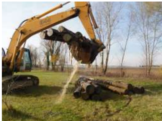
Figure 30 : Extraction des fagots du lac à la pelle mécanique
