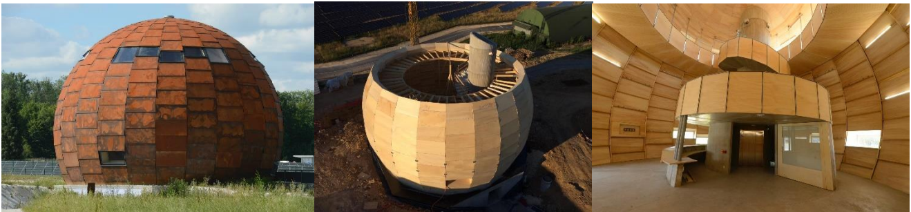
Figure 19: Maison solaire à Toul-Rosières (54) [31] - Réalisée par SAS Cartignies Canonica Architecture
