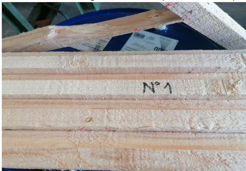
Figure 62: Photo des différentes fissures suite à rupture de la dalle 1
