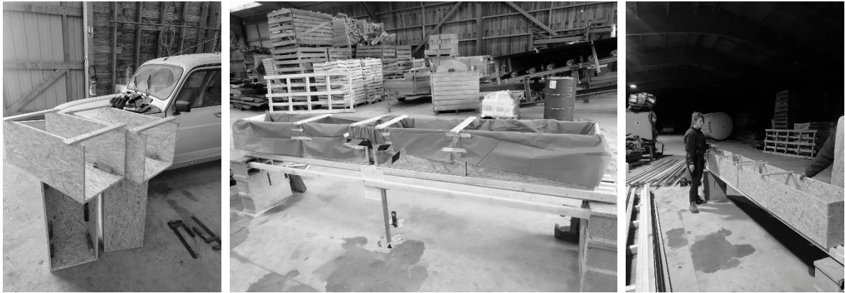
Figure 60: Chargement du sable dans les caissons
