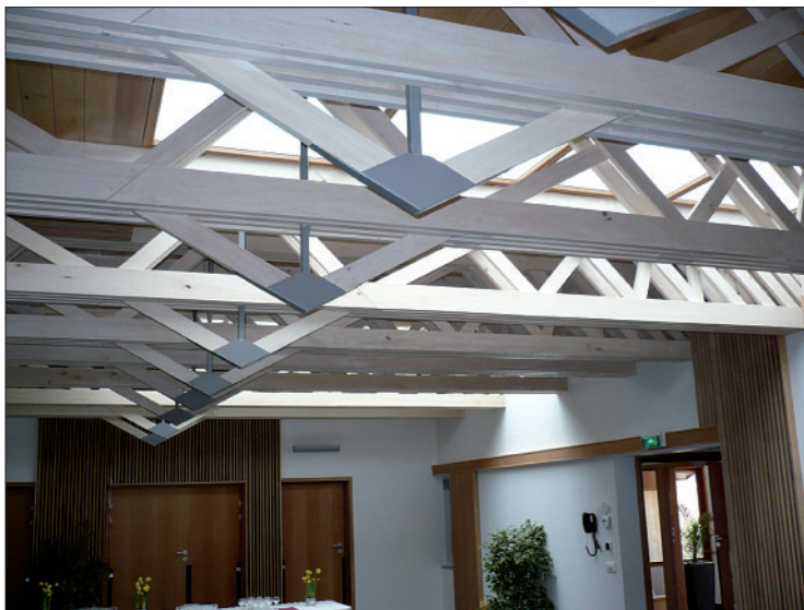
Photo 3 Illustration d'une réalisation peuplier dans la construction avec la charpente de la salle Grémaux à Lezennes (Nord).
