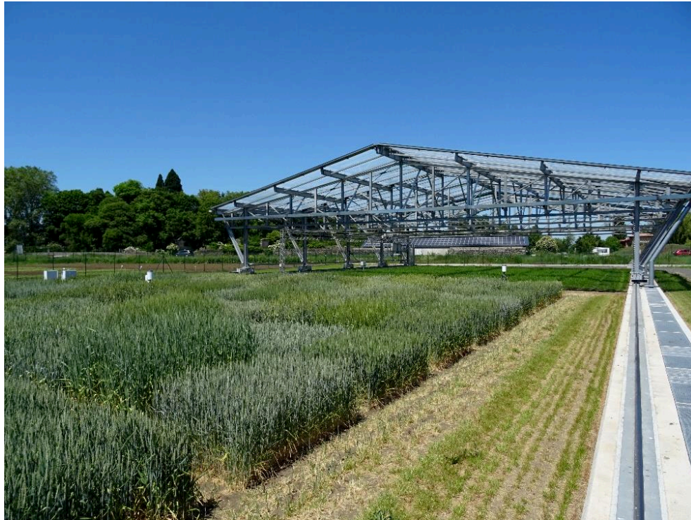
Figure 62 : Vue du dispositif d'exclusion de pluies permettant d'étudier la réponse du blé à un stress hydrique. Sur cette photographie, une des quatre parcelles « abritées » avec en fond le toit amovible qui vient la recouvrir en cas de précipitations.
